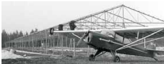
Træhangaren bygges. OY-DGY holder foran - idag er den gul og stationeret i Spjald
